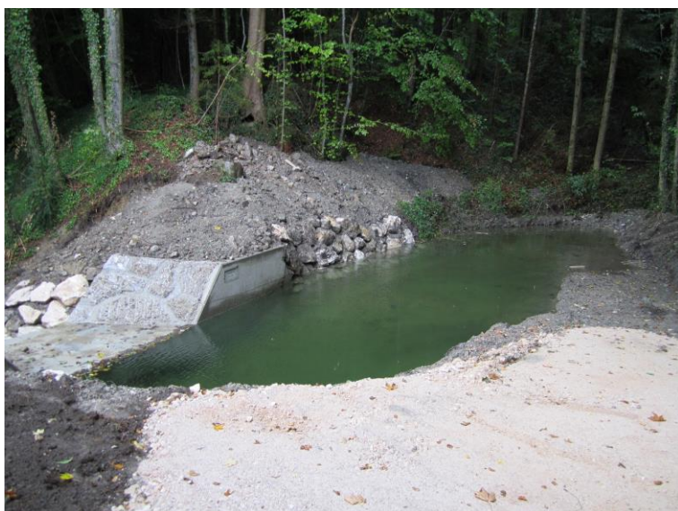
Abb. 1: Kiesfang Gastager Graben mit neuer Sperre
